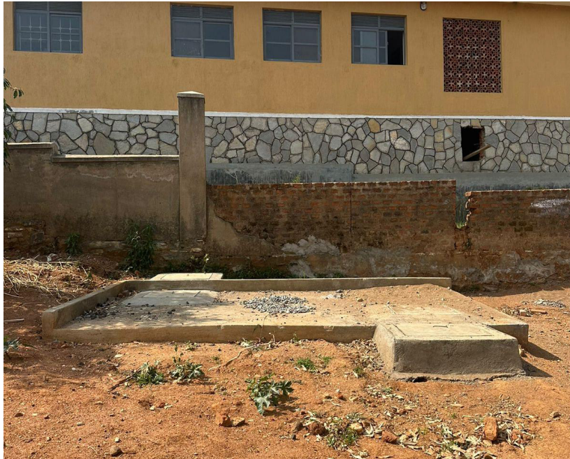
Construcción de cámara séptica:
