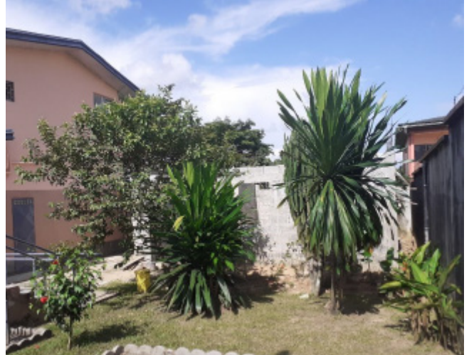
Espacio donde se está construyendo el taller
